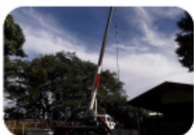
Instalacion de bomba de pozo nueva.
