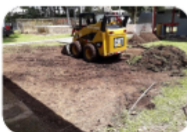
Preparación del terreno para losa de concreto.
