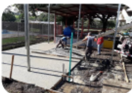
Chorrea de losa con concreto premezclado.
