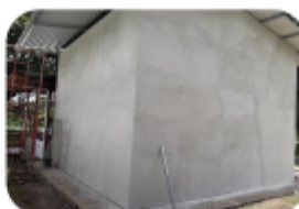
Paredes de fibrocemento instaladas.
