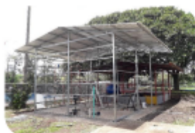
Instalación de techo y paredes de fibrocemento.
