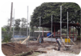
Armado de estructuras de la caseta.
