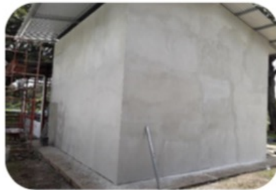
Paredes de fibrocemento instaladas.
