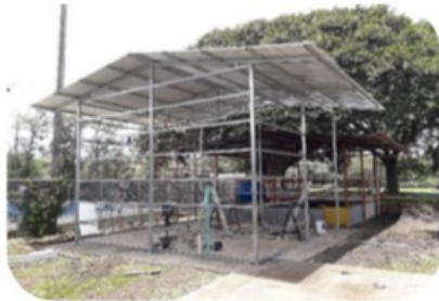
Instalación de techo y paredes de fibrocemento.
