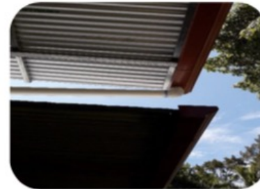
Canoas y bajantes de canoas instalados en el techo.
